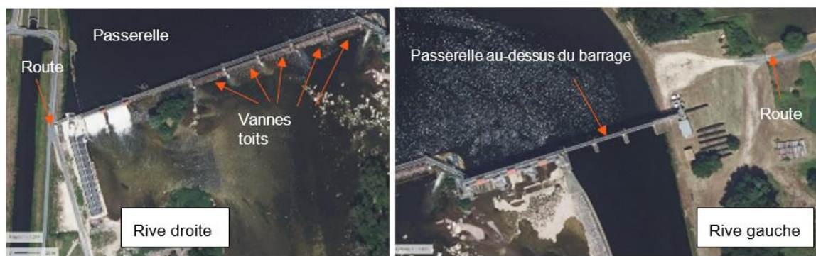
Figure 23 : Accès par la rive droite et rive gauche.
