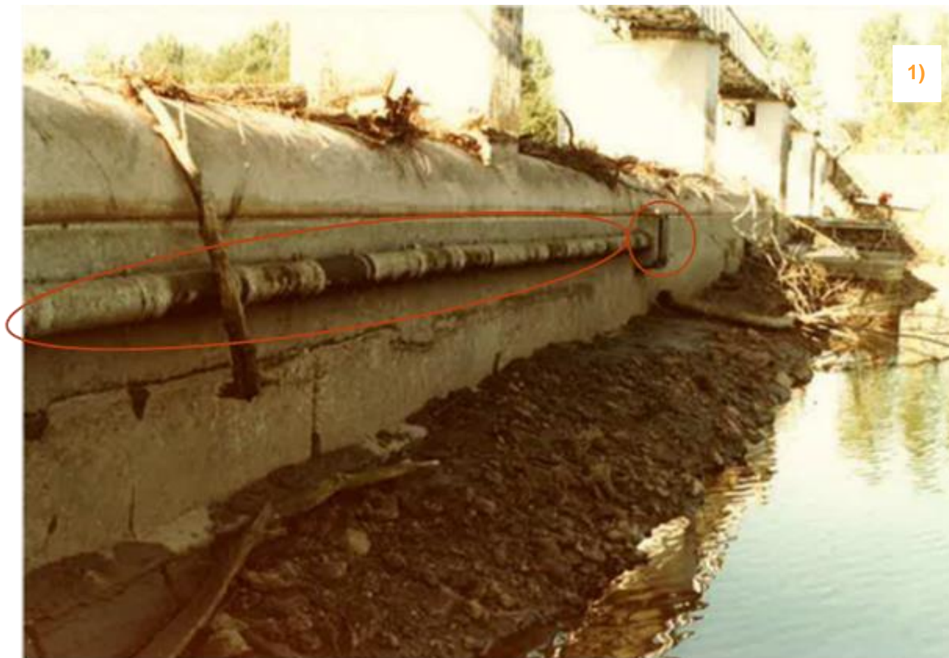
Figure 16 : Réfection tuyau et grille d'équilibrage.
