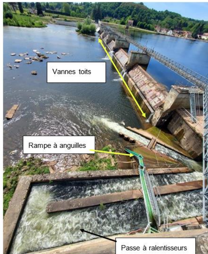
Figure 6 : Vue des vannes toits, rampe à anguilles et passe à ralentisseurs (HSM, 2022).
