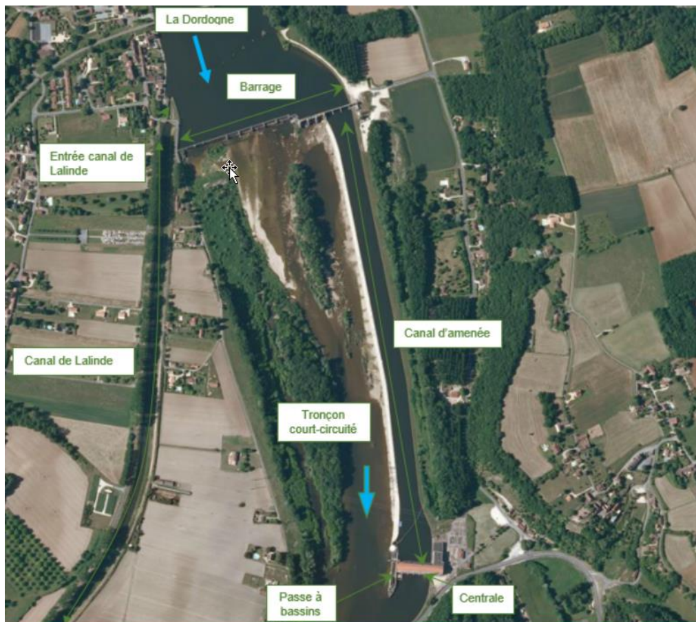
Figure 2 : Vue générale de l'aménagement de Mauzac (Géoportail, 2022).
