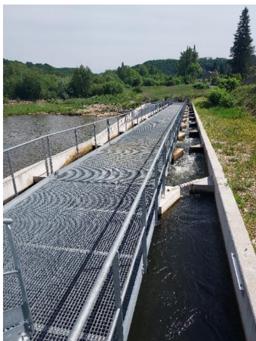
Figure 5 : Vue de la passe à poissons (HSM, 2022)
