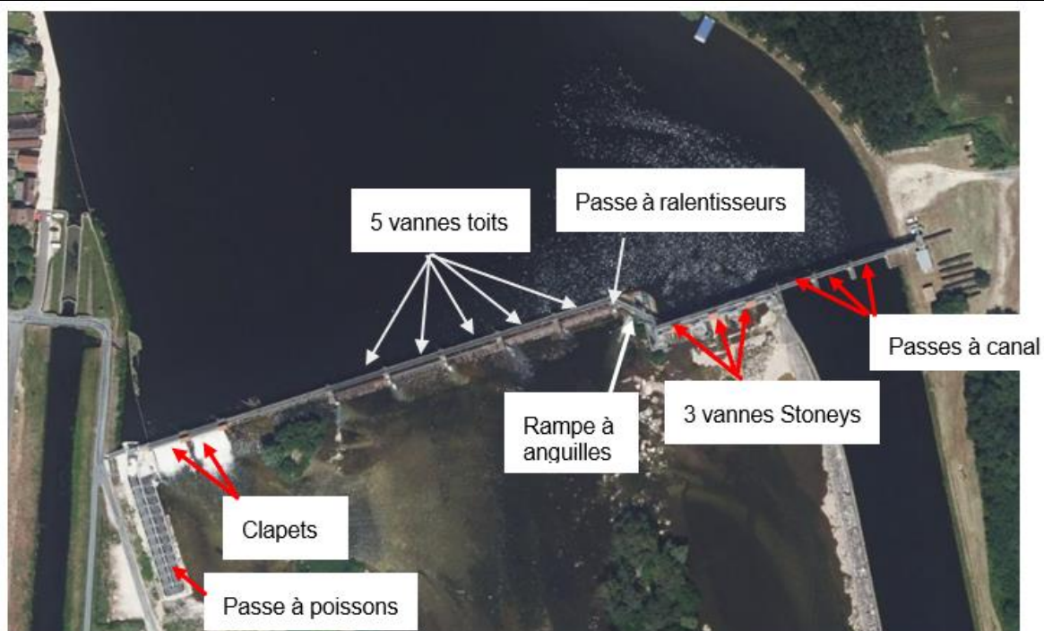
Figure 3 : Vue du dessus du barrage de Mauzac (Géoportail, 2022).
