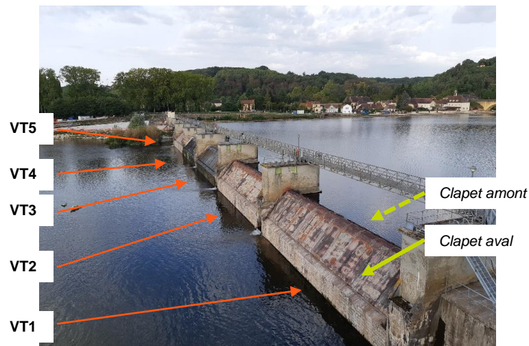
Figure 2 : Repérage des vannes dans leur environnement
